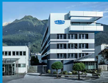
Sede central de Tyrolit en Schwaz (Austria)
